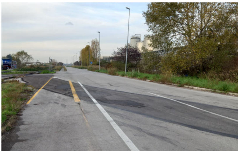
Figura 7 Attraversamento sud di via Majorana, con il ripristino della pavimentazione lungo il vecchio tracciato.
